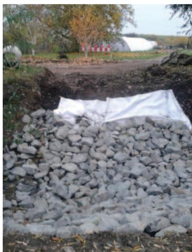
Der Bereich des Dükers - hinter dem Ortsausgang durch den Weißbach „geschossen“ - wurde mit Flussbausteinen gesichert und befestigt.
