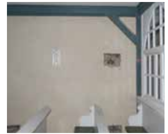
Die Ringanker (von außen und von innen)
