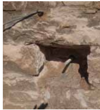
Die Ringanker (von außen und von innen)
