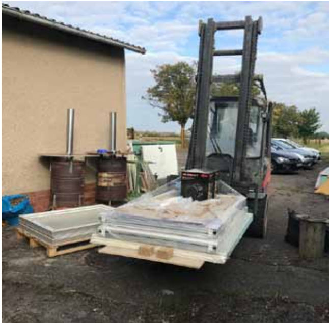
Anlieferung der neuen Fenster und Türen, die bereits alle eingebaut worden sind.
