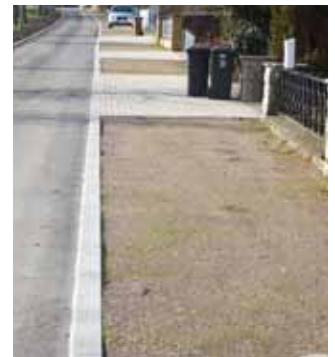
Die fertiggestellte Straße mit festgeschottertem Randstreifen. Umpflasterter Kontrollschacht der Planumsentwässerung (li).
