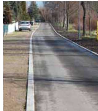
Die fertiggestellte Straße mit festgeschottertem Randstreifen. Umpflasterter Kontrollschacht der Planumsentwässerung (li).
