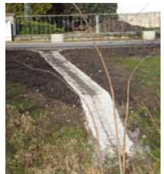
Gepflasterte Kaskade zur Straßenentwässerung (re).
